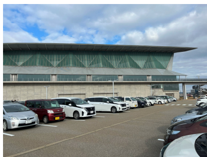
いしかわ総合スポーツセンター
